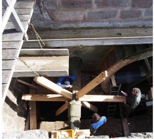
In der sauberen Radstatt beginnt der Einbau des neuen Rades mit dem Einsetzen der drei Speichen in den Wellbaum. Zunächst werden die Speichen ausgerichtet und ihr Sitz im Wellbaum justiert. Sie müssen genau mittig im Wellbaum sitzen, damit das Rad gleichmäßig läuft. Durch die Überblattung sind sie fest ineinander verschränkt. Das ist wichtig für den weiteren Aufbau, denn genau an diesem Punkt wird die Energie der Drehbewegung auf das Getriebe im Inneren der Mühle übertragen.
