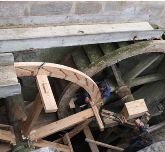
Innere und äußere Felge werden komplett gesetzt, so dass der Radkranz fertig aufsitzt. Er bildet die Basis zum Einstecken der Schaufelhölzer und für den weiteren Aufbau. *Leon Söllner*
