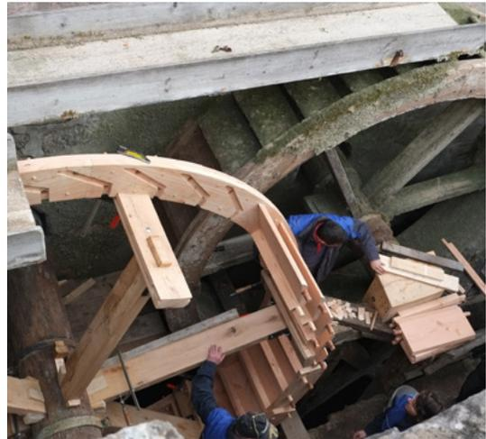
Den Bohrungen und Einstimmungen entsprechend werden die Riegel- und Setzschaufeln paarweise eingesetzt. Das Einsetzen erfolgt abschnittsweise, denn Segment für Segment werden unmittelbar die beiden Felgen des äußeren Radkranzes auf die Schaufelhölzer gesetzt. *Leon Söllner*
