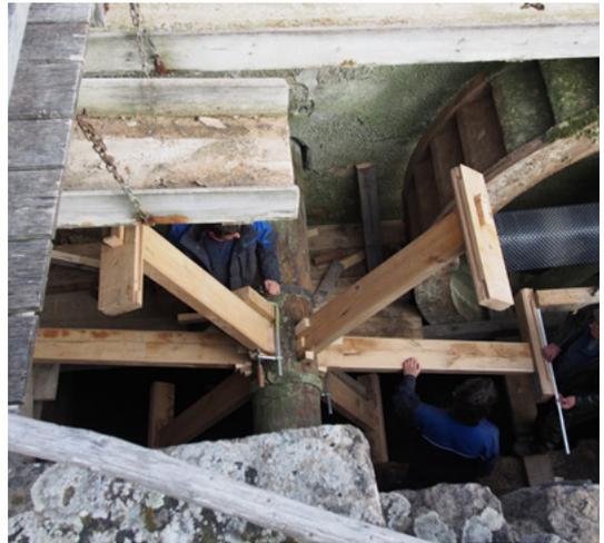
Erst wenn die Speichen im Wellbaum fixiert und aufeinander ausgerichtet sind, folgt das Aufsetzen der Kopfhölzer. Sie werden in die Waage gesetzt und in ihrer Position auf die Speiche und auf das gegenüberliegende Kopfholz ausgerichtet und durch kleine Keile fixiert. *Leon Söllner*
