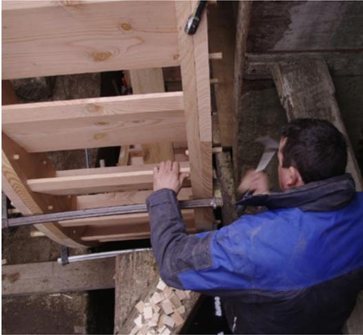
Ein Holzkeil, der jeweils in die Zapfen der Schaufelhölzer geschlagen wird, stabilisiert das Gefüge. Der Holzkeil wird in eine quer im Zapfen angelegte Fuge eingesetzt und festgeschlagen. *Leon Söllner*
