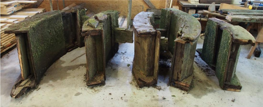
Die Einzelteile des alten Wasserrades in der Abbundhalle. Hier werden die verschiedenen Elemente des neuen Rades ausgearbeitet, zusammen gepasst und für den Aufbau gekennzeichnet. Die Ausarbeitung erfolgt mit Handwerkzeugen, großen Handmaschinen und stationären Maschinen. *Juliane Sander*
