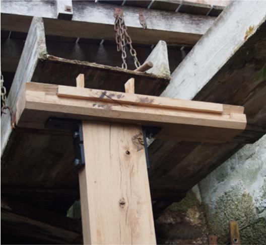
Mit eigens in der Schmiede des Bauhofs gefertigten Winkeln wird die Verbindung von Kopfholz und Speiche zusätzlich fixiert. *Leon Söllner*
