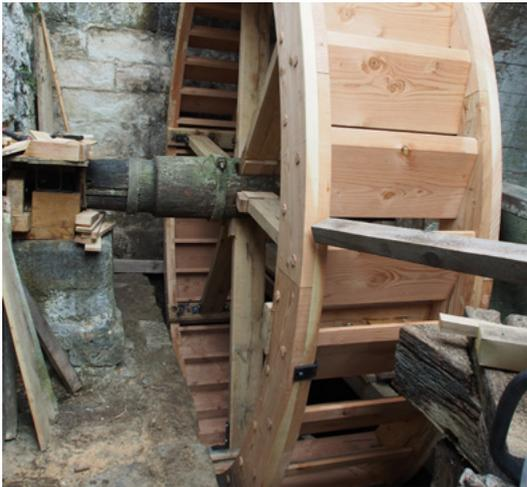
Nachdem der innere und der äußere Radkranz mit den dazwischen sitzenden Kammern aufgebaut sind, wird das Rad endgültig ausgerichtet, damit es gleichmäßig läuft, um eine Unwucht zu vermeiden. *Juliane Sander*
