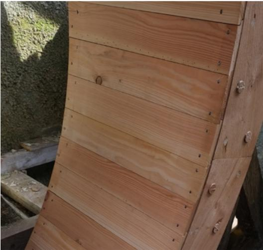
Als letzte Elemente werden die Schalbretter auf der Innenseite des Radkranzes gesetzt. Sie bilden die Böden der Kammern. Jedes Brett wird vernagelt. *Leon Söllner*
