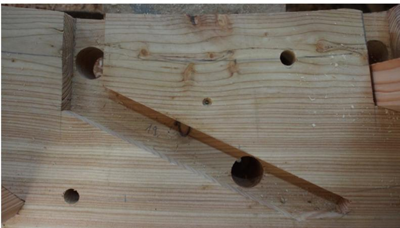
Neben den eingestemten Feldern mit Zapfenlöchern für die Schaufelhölzer liegen die Löcher für die Holznägel. Durch sie werden die beiden Felgen eines Radkranzes zusätzlich zusammengehalten. Ihr Durchmesser beträgt 18 Millimeter.
