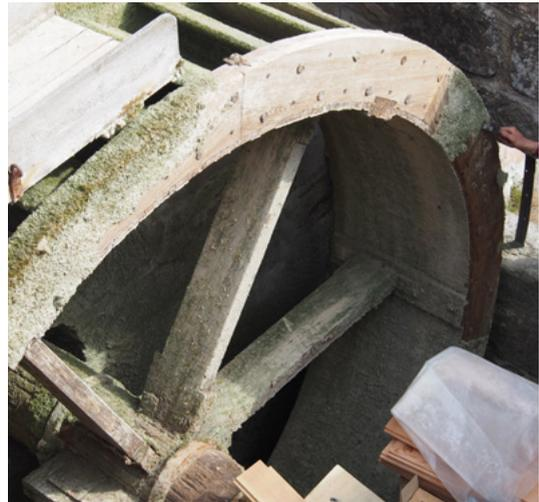
Während des Einbaus der Schalbretter beginnt die mühselige Säuberung des bestehenden Schrotgang-Mühlrads: Mit verschiedenen Spachteln und Wasser gelingt es, den Belag abzulösen. Wie an den Wänden der Radstatt hat sich auch am Mühlrad eine millimeterdicke und feste Schicht aus Kalk, Staub und pflanzlichem Bewuchs gebildet. Sie sieht nicht nur ungepflegt aus, vor allem schadet sie dem Holz – beispielsweise fördert sie das Zersetzen. *Juliane Sander*
