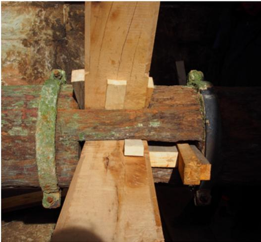
Dann werden sie mit kleinen Keilen fixiert. Später, wenn das Rad fertig aufgebaut ist, werden die kleinen Keile durch größere, festsitzende ausgetauscht. *Leon Söllner*
